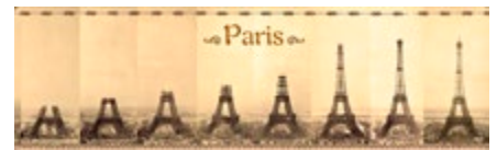
La tour Eiffel en construction - PEIF-01
