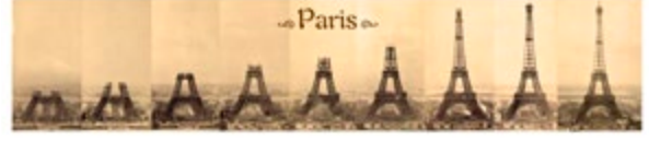
Tour Eiffel en construction ~ BP-PAEFO1
